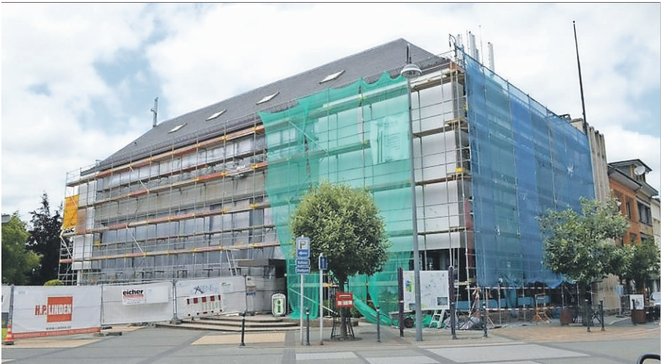
Die energetische Sanierung des St.Vither Rathauses war eines der großen Projekte im vergangenen Jahr. Foto: GE-Archiv
