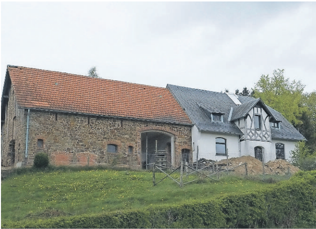
Am Ortsausgang Richtung Medendorf entsteht im alten Forsthaus das Dorfhaus mit zwei Wohnungen.
